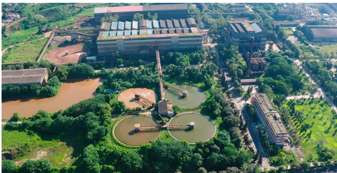
Nhà máy tuyển Tăng Loong - Công ty Apatit Việt Nam chủ động áp dụng các giải pháp tuần hoàn nước thải
