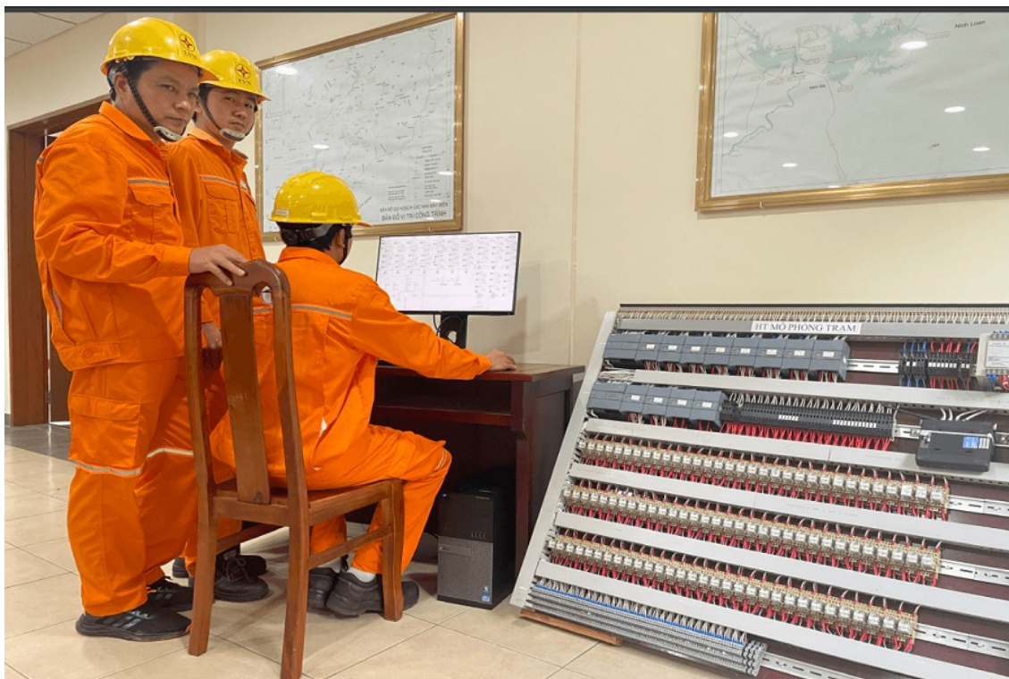
Cán bộ, công nhân viên thực hành trên Hệ thống mô phỏng trạm phân phối 220/110kV Đại Ninh. Ảnh: T.T.
