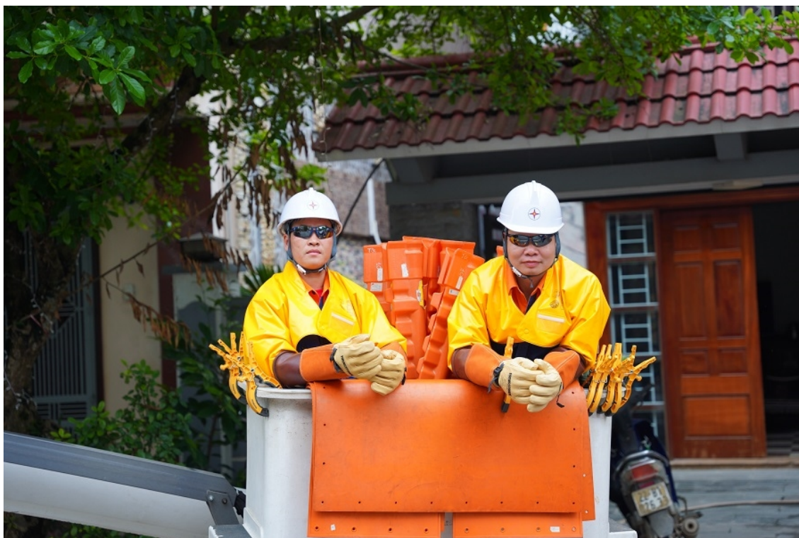
Trang phục bảo hộ lao động của các nhân viên Đội sửa chữa Hotline Công ty Điện lực Tuyên Quang khi làm việc trên đường dây 22kV
