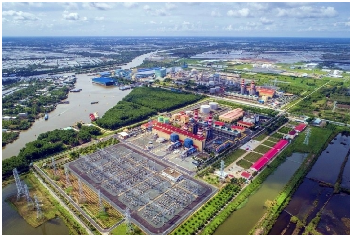
Cụm Khí-Điện-Đạm Cà Mau
