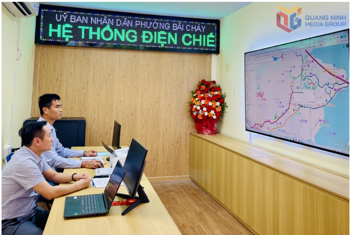
Trung tâm Quản lý theo dõi, vận hành và điều khiển hệ thống chiếu sáng công cộng phường Bãi Cháy (Ảnh: QMG)
