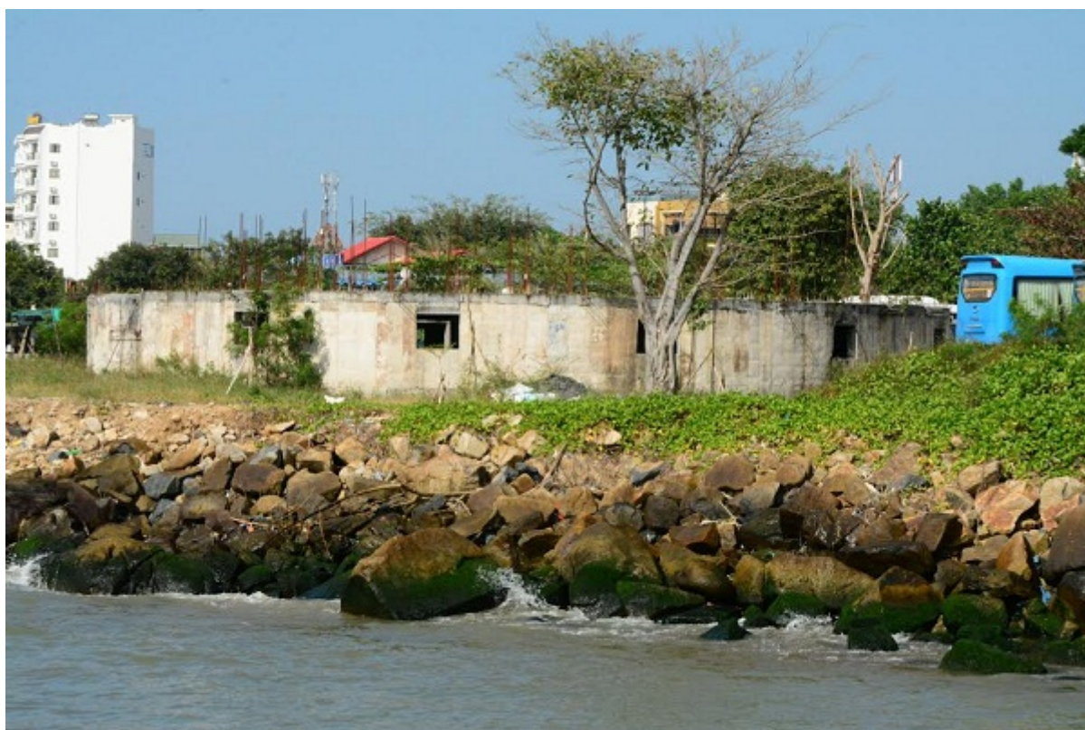
Khu công trình ngầm quán cà phê (6) như một “lô cốt” dở dang (chụp 9/2/2017)
