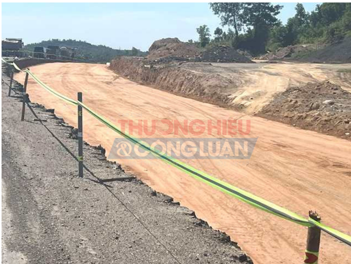
Dự án đường cao tốc đoạn Hòa Liên - Túy Loan thi công từ tháng 9/2023 với tổng chiều dài 11,5 km
