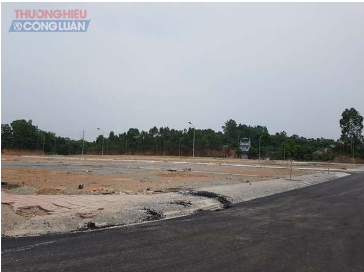
Khu đất dự án
