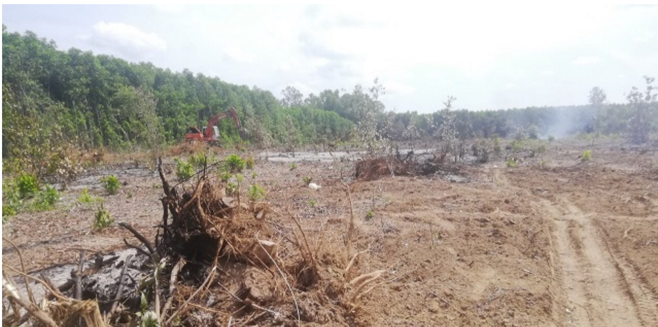
Dự án đang là vạt rừng tràm vừa bị đốn bỏ và đang san lấp mặt bằng (Ảnh: Lê Bảo)
