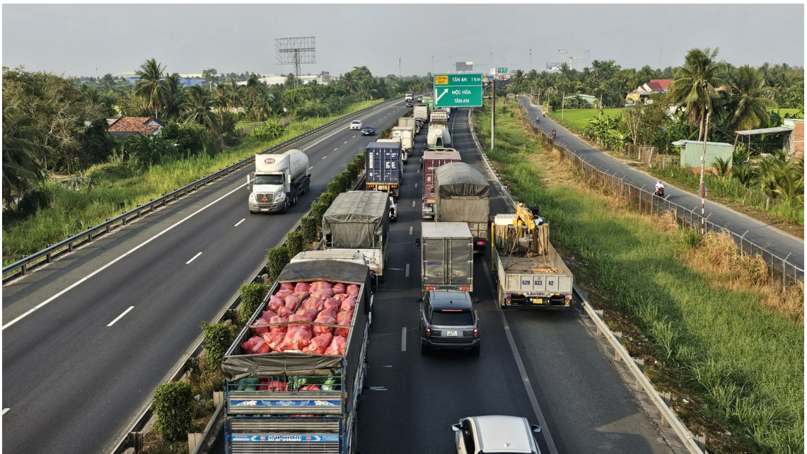
Cao tốc TP. HCM - Trung Lương - Mỹ Thuận dự kiến khởi công mở rộng cuối năm nay (Ảnh: Huỳnh Du)
