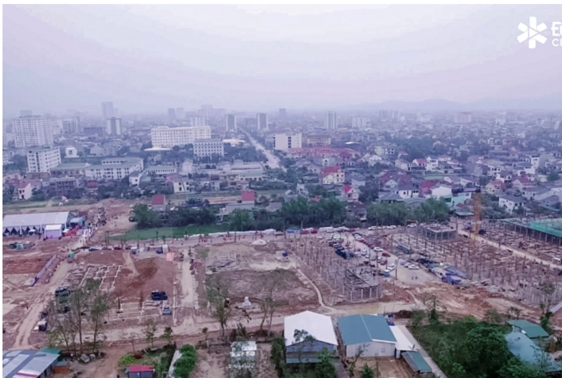
Dự án Eurowindow Holding tại phường Vinh Phú và Vinh Lộc từ trên cao.
