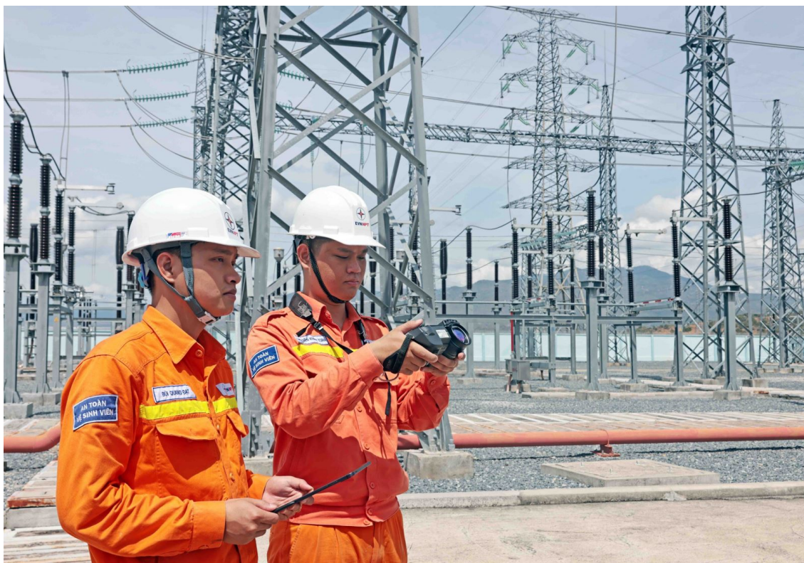
Cán bộ ngành điện giám sát trạm biến áp. Ảnh: Trần Việt/TTXVN
