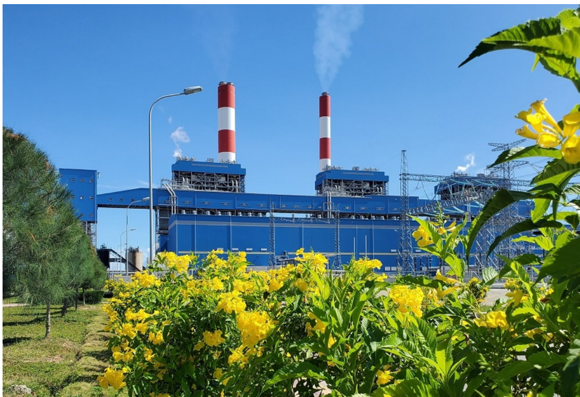
Nhà máy Nhiệt điện Vĩnh Tân 4.
