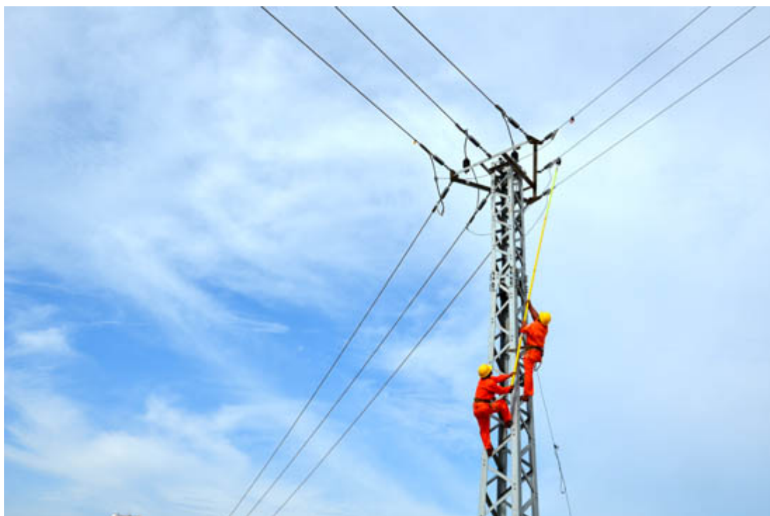
EVN hoàn thành nhiều công trình lưới điện
