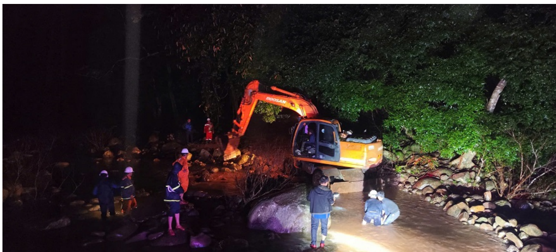
Thi công xuyên đêm để “phủ điện” tại bản Dốc Mây, Quảng Trị
