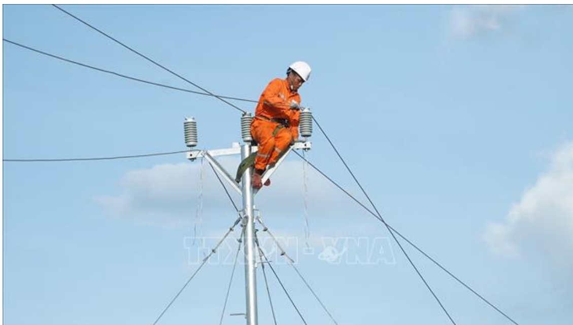
Cán bộ Công ty điện lực Hà Tĩnh sửa chữa đường dây bị hư hỏng do bão số 10. Ảnh: Hữu Quyết/TTXVN
