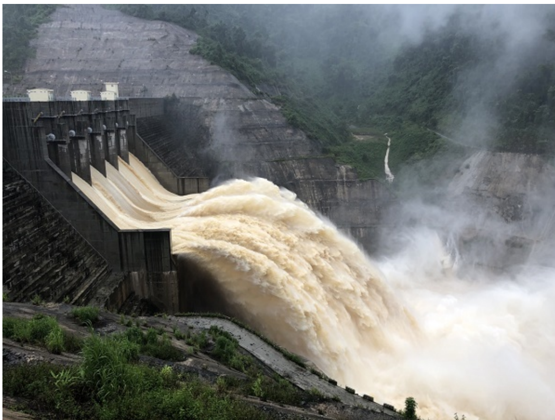
Nhà máy Thủy điện Sông Bung 4 xả điều tiết qua tràn theo chỉ đạo của Ban Chỉ huy PCTT&TKCN tỉnh Quảng Nam, tháng 10/2020
