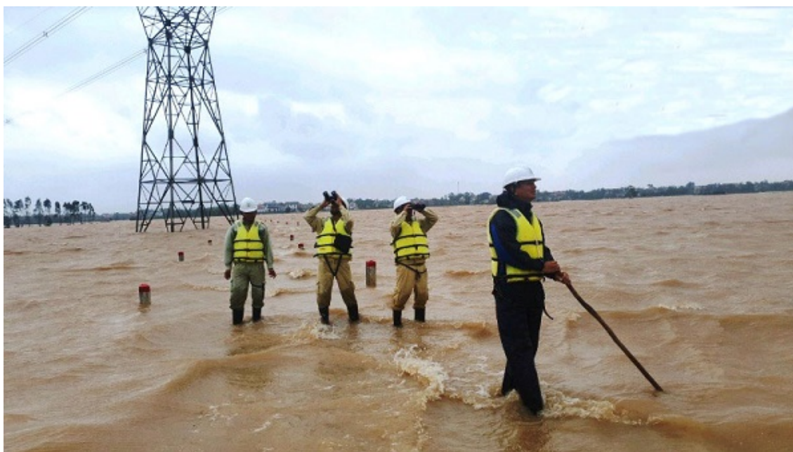
Công nhân Truyền tải điện Quảng Bình kiểm tra lưới điện sau mưa bão, năm 2020
