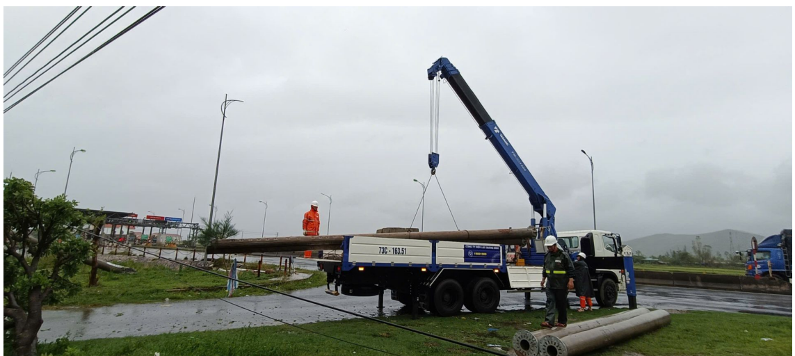
PC Quảng Trị ra quân khắc phục sự cố lưới điện do ảnh hưởng của bão số 10 trong sáng sớm 29/9
