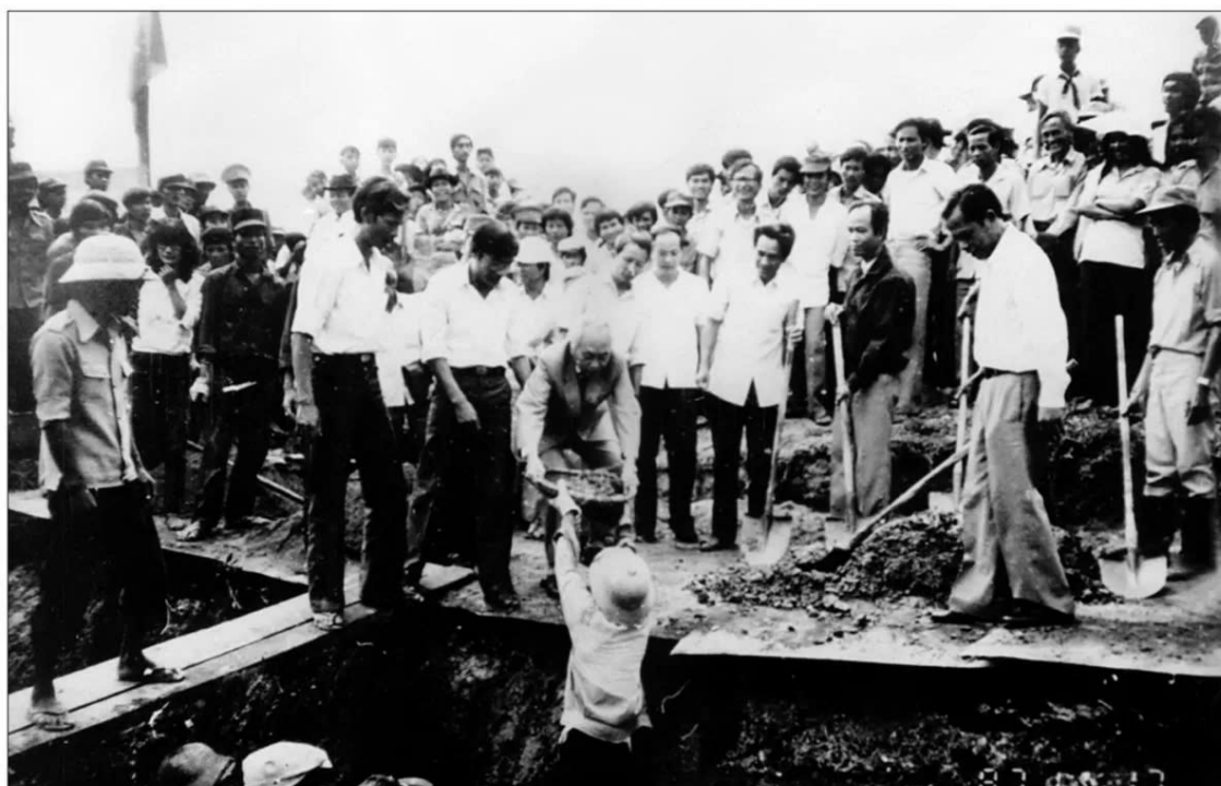
Đại tướng Võ Nguyên Giáp đổ bê tông đầu tiên xây dựng đường dây 110kV Huế - Đà Nẵng năm 1987. (Ảnh tư liệu)
