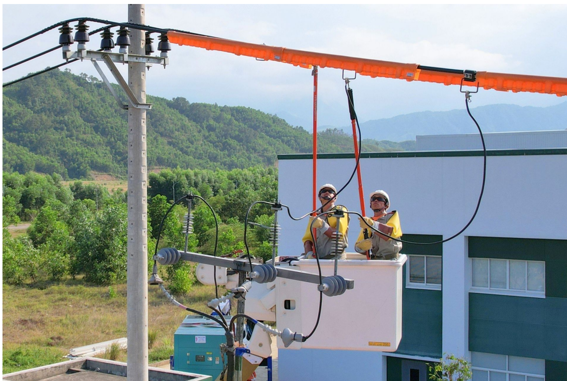
EVNCPC ứng dụng công nghệ sửa chữa nóng lưới điện
