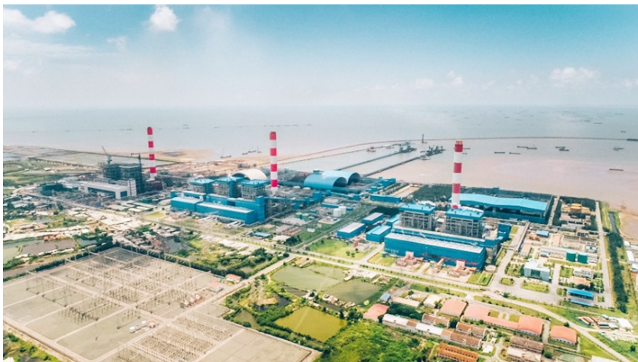
Nhà máy Nhiệt điện Duyên Hải 1 và Nhà máy Nhiệt điện Duyên Hải 3.
