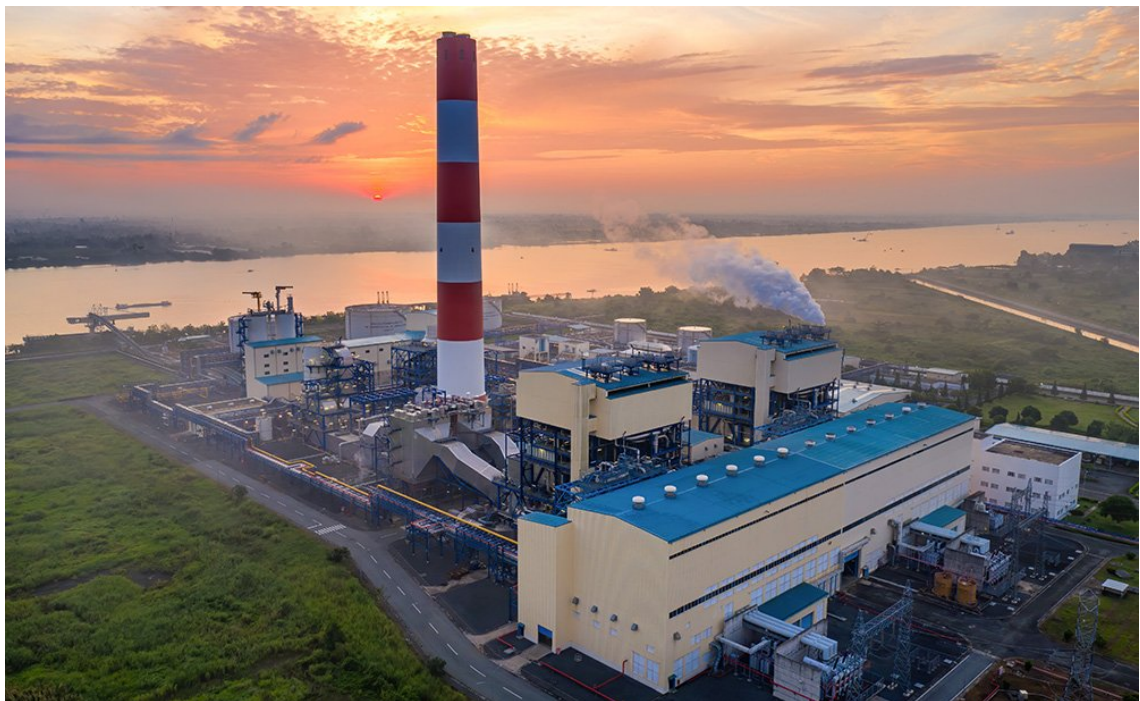
Nhà máy Nhiệt điện Ô Môn I. Nguồn ảnh: ĐVCC
