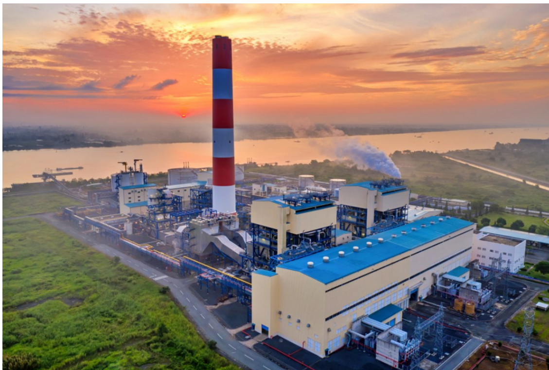
Nhà máy Nhiệt điện Ô Môn - Công ty Nhiệt điện Cần Thơ, đơn vị thành viên của EVNGENCO2
