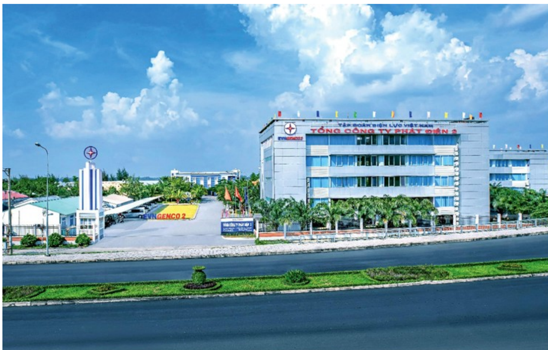
Trụ sở Tổng công ty Phát điện 2
