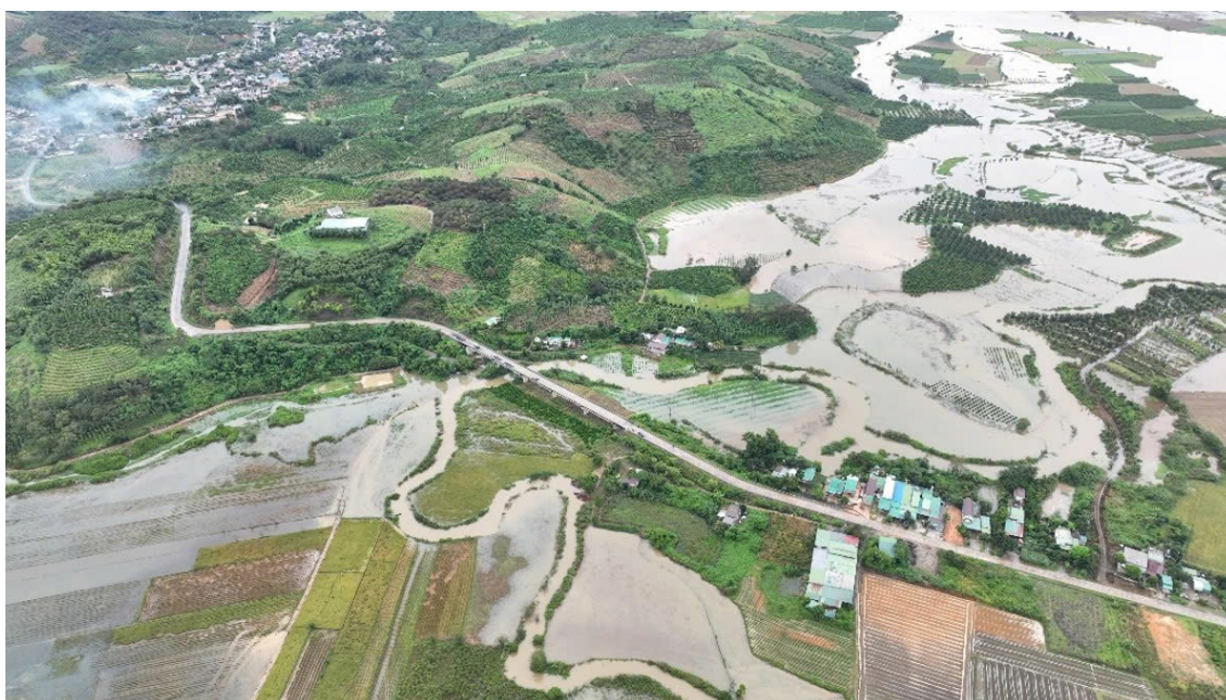
Toàn cảnh hạ du Nhà máy Thủy điện Buôn Tua Srah (tỉnh Đắk Lắk)
