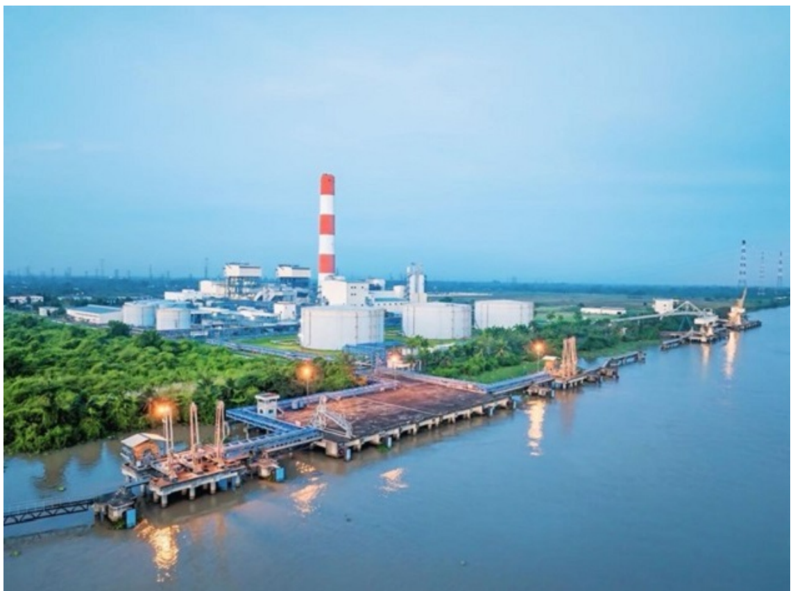
Nhà máy nhiệt điện Ô Môn 1
