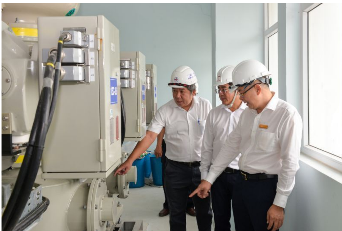
Tổng giám đốc Nguyễn Văn Thanh (ngoài cùng bên phải) kiểm tra công trình đầu tư xây dựng dự án lưới điện truyền tải. Ảnh: EVNHCMC
