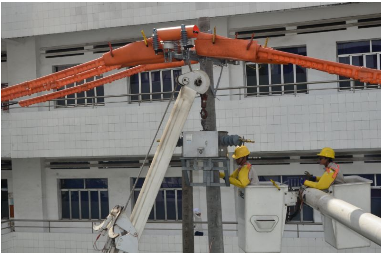
Công nhân EVNHCMC thi công trên đường dây đang mang điện (thi công live-line) (Ảnh: EVNHCMC)
