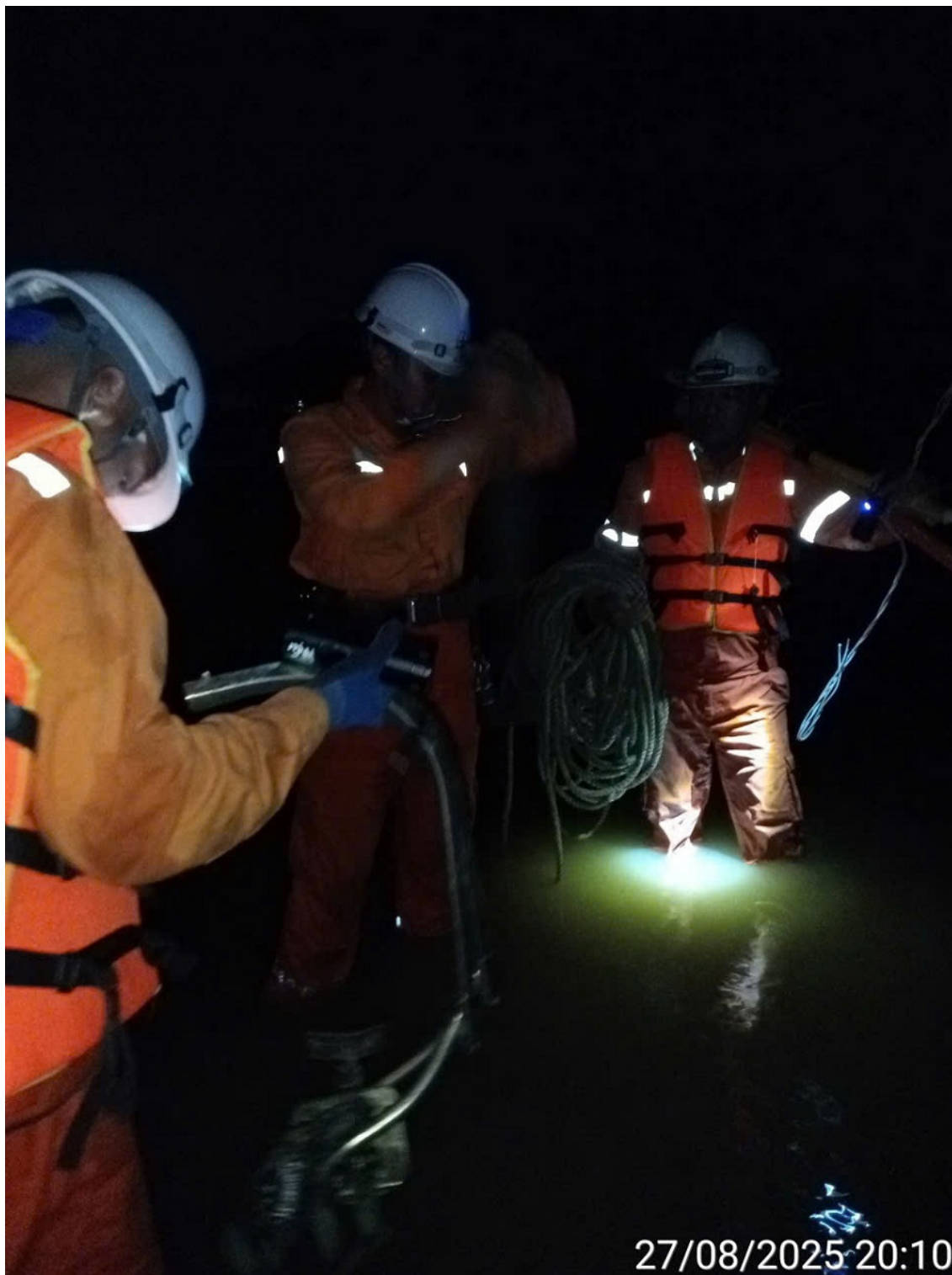
Đội xung kích PC Quảng Ninh đang nỗ lực khắc phục ĐZ 35 kV lộ 384 E18.11 Nghi Xuân Hà Tĩnh, đấu nối để cấp điện lại cho khách hàng
