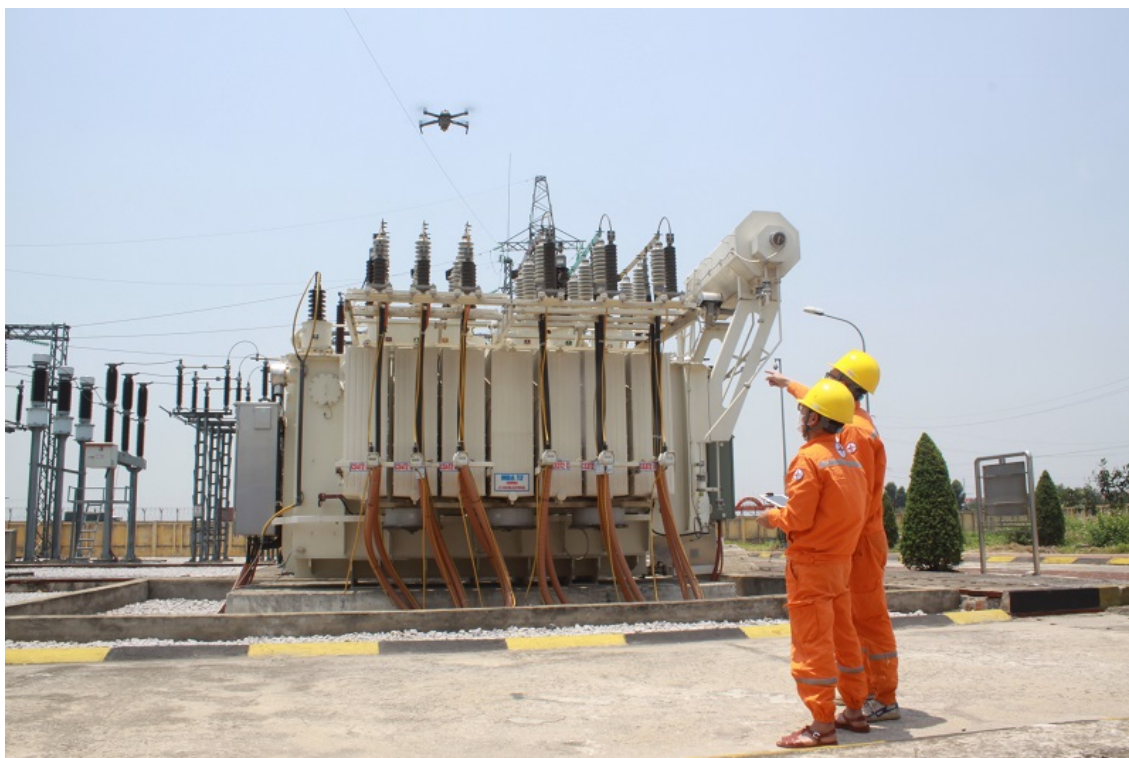
Kiểm tra lưới điện bằng thiết bị bay Flycam.
