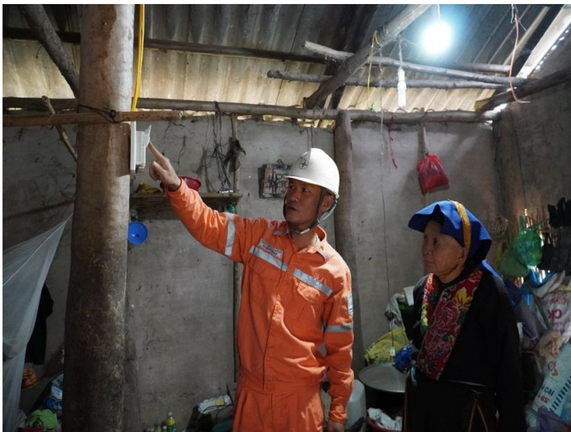
Công nhân Điện lực Ba Chẽ sửa chữa điện cho hộ nghèo nhân Tháng Tri ân khách hàng năm 2022
