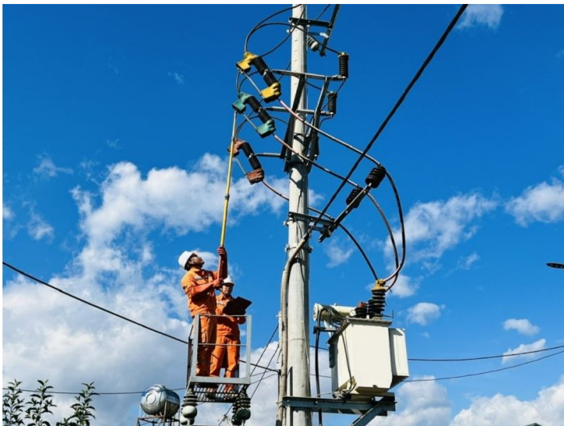
Công ty Điện lực Lai Châu đóng điện TBA thuộc dự án đầu tư xây dựng năm 2023
