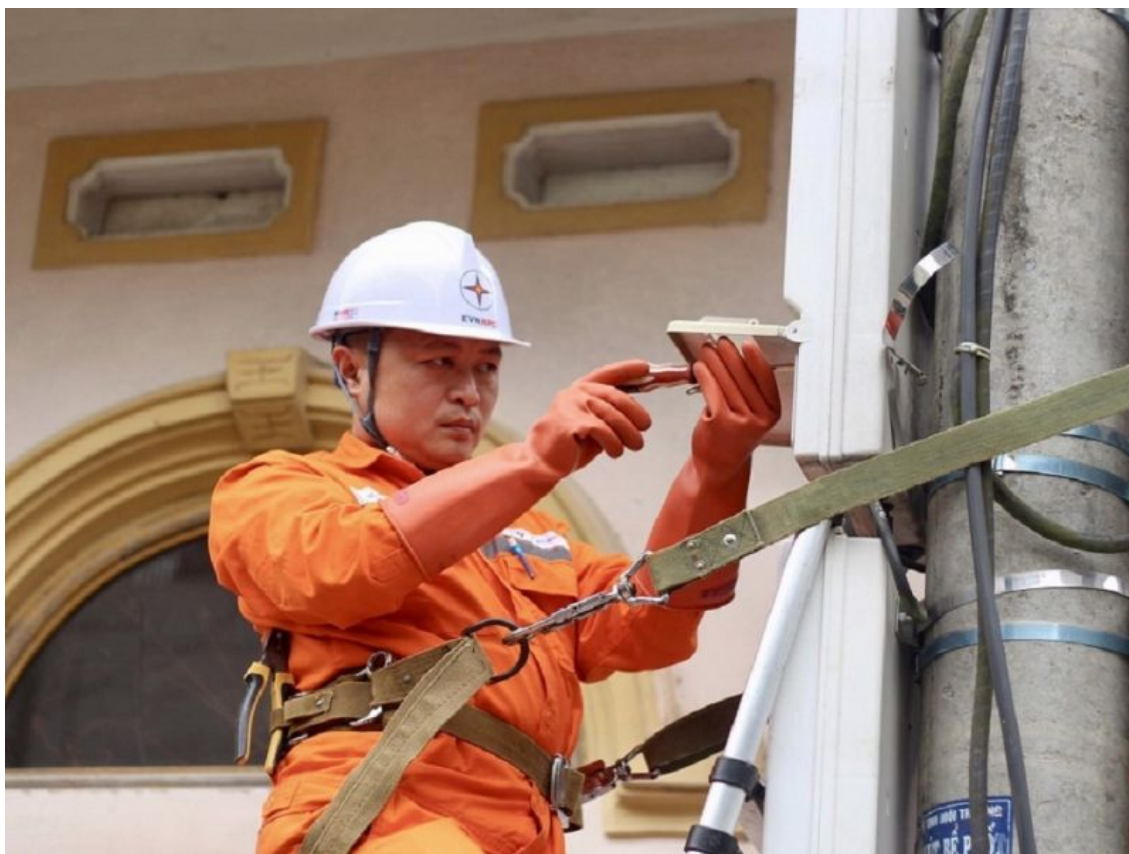
Công nhân Điện lực Văn Lăng (PC Lạng Sơn) thực hiện thay thế hệ thống công tơ tại TBA Miễn Thuế 1.
