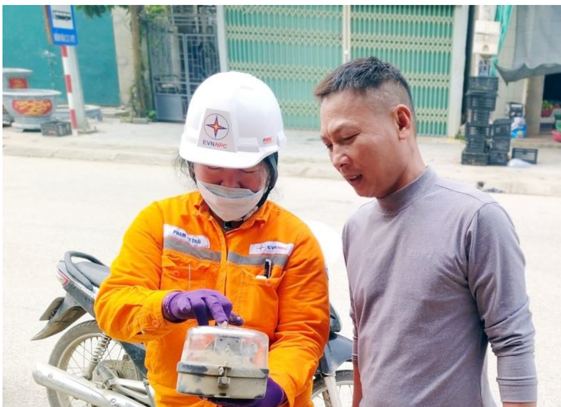
Công nhân Điện lực khu vực Bầm Sơn - Hà Trung (PC Thanh Hóa) hướng dẫn khách hàng xem và chốt chỉ số trên công tơ cơ khí cũ trước khi thay thế bằng lắp đặt công tơ điện tử.
