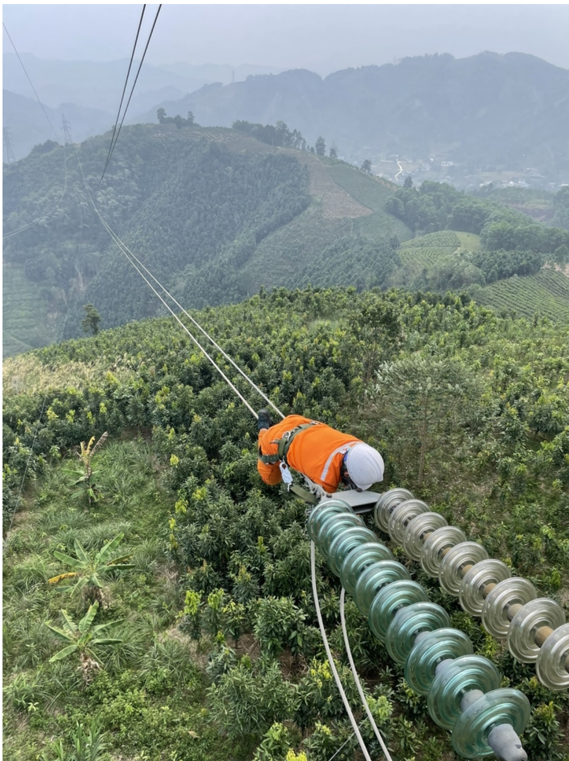
Công nhân quản lý vận hành đường dây 110kV khắc phục khiếm khuyết trên đường dây (PC Yên Bái).
