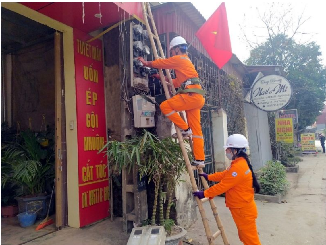
Công nhân Điện lực khu vực Bỉm Sơn - Hà Trung (PC Thanh Hóa) tháo công tơ cơ khí cũ để thay thế bằng công tơ điện tử đo xa.
