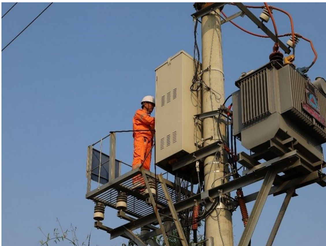
Kiểm tra bảo dưỡng hệ thống lưới điện.
