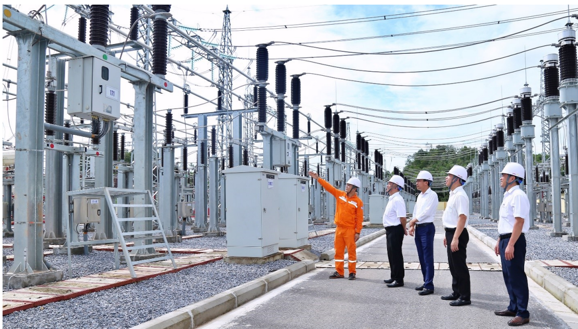
Lãnh đạo EVNNPC kiểm tra hiện trường dự án trước khi bàn giao đóng điện
