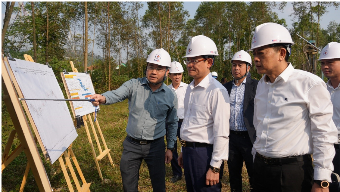
Tổng Giám đốc EVNNPC Nguyễn Đức Thiện kiểm tra thực địa, chỉ đạo công tác tổ chức thi công công trình xuất tuyến 110kV sau Trạm biến áp 220kV Bá Thiện (Phú Thọ)
