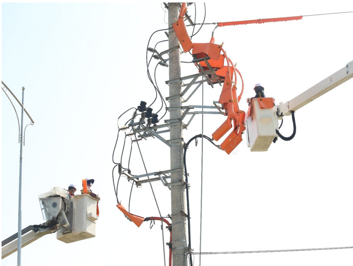
Đội Hotline thực hiện sửa chữa, khắc phục khiếm khuyết, đấu nối đường dây
