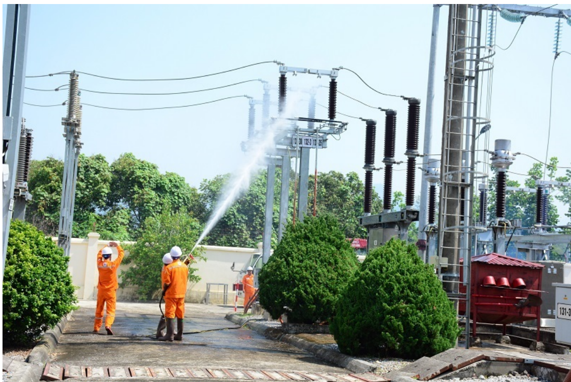
Vệ sinh công nghiệp lưới điện
