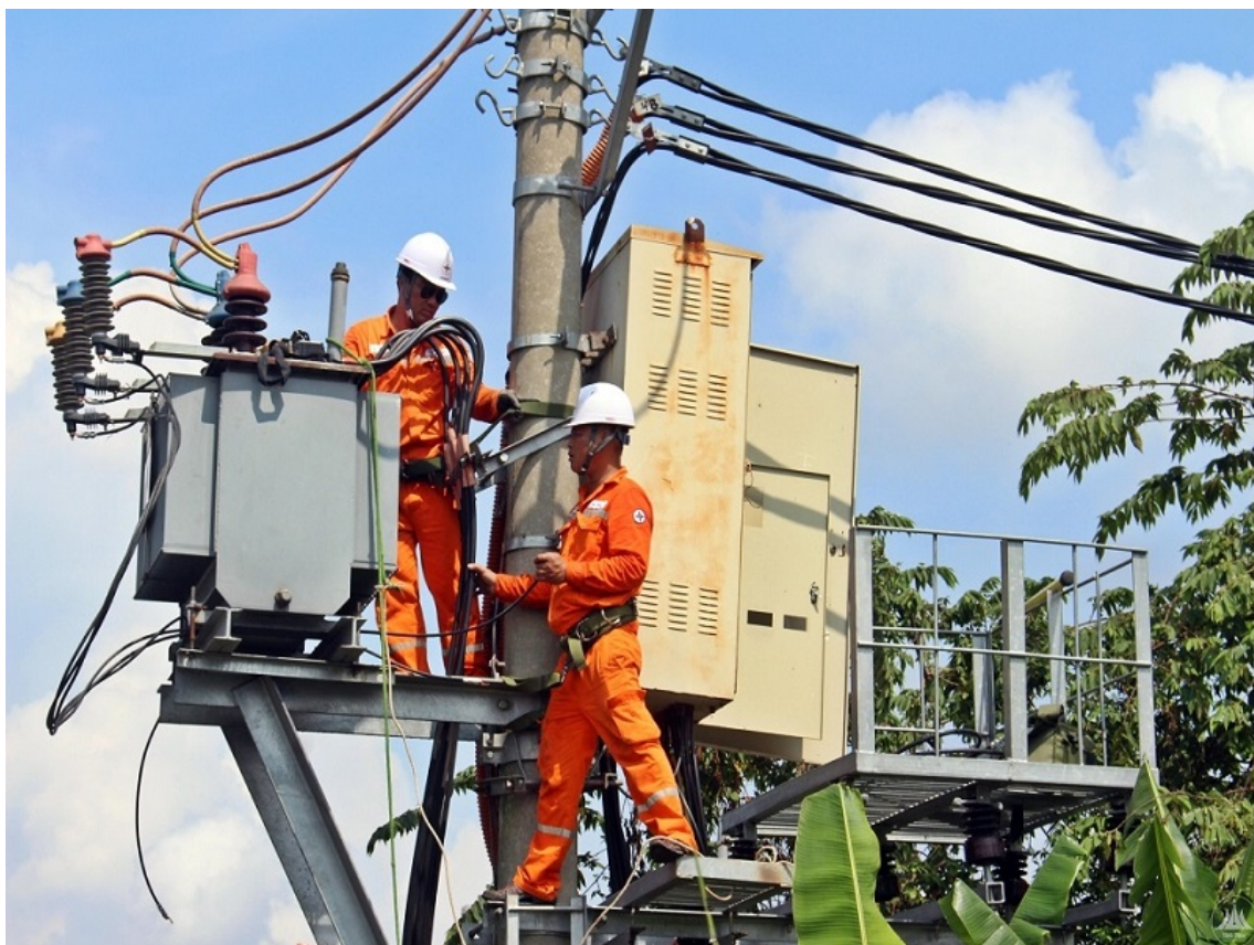
PC Vĩnh Phúc kiểm tra bảo trì hệ thống lưới điện
