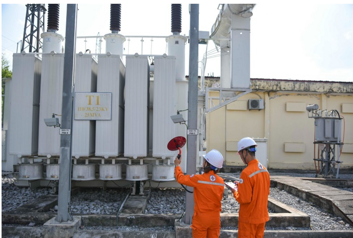
Công nhân Đội Quản lý vận hành lưới điện cao thế Điện Biên định kỳ kiểm tra thiết bị trạm 110kV bằng máy phóng điện cục bộ (PD)
