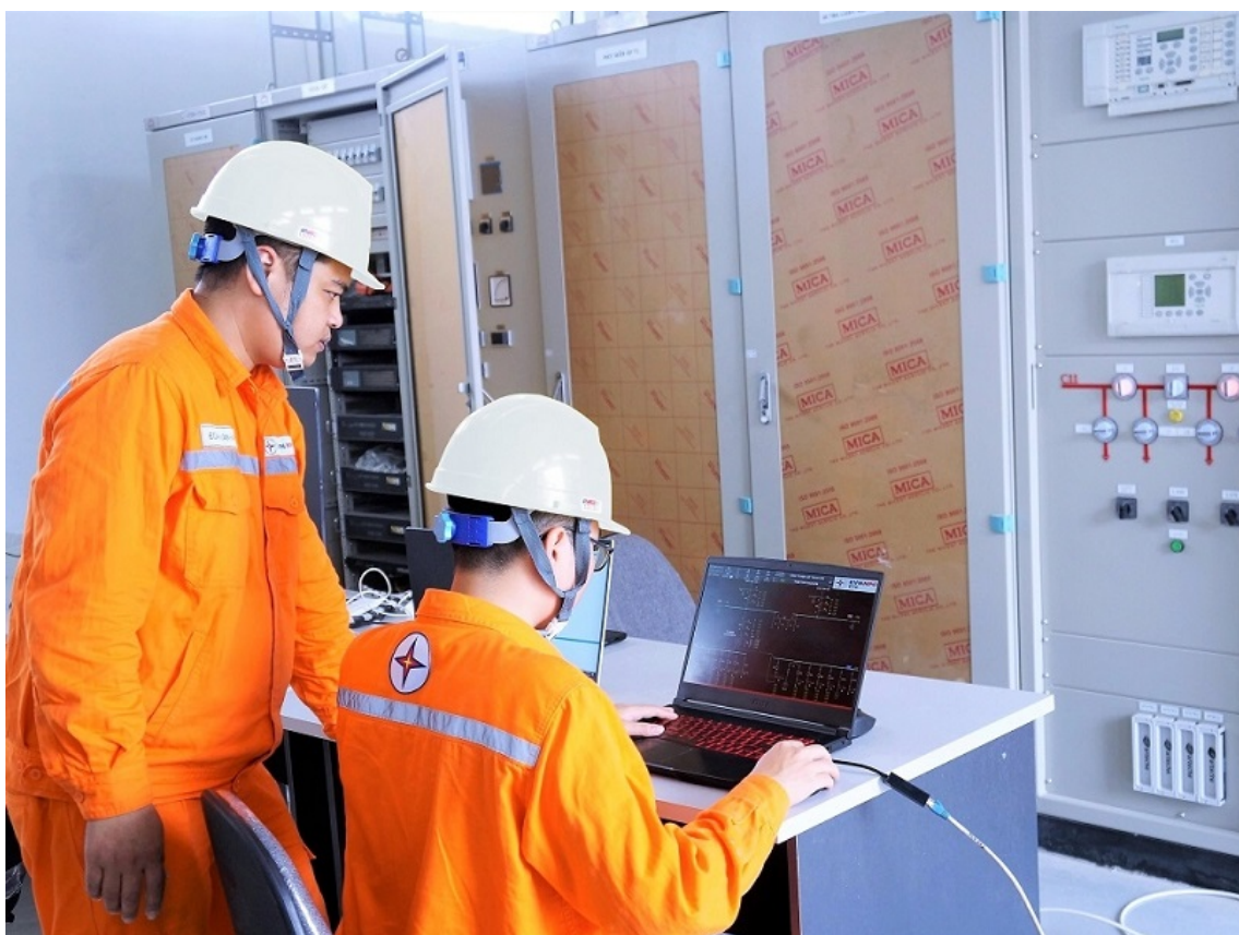
Thí nghiệm, cài đặt trước khi đưa vào vận hành TBA 110kV không người trực
