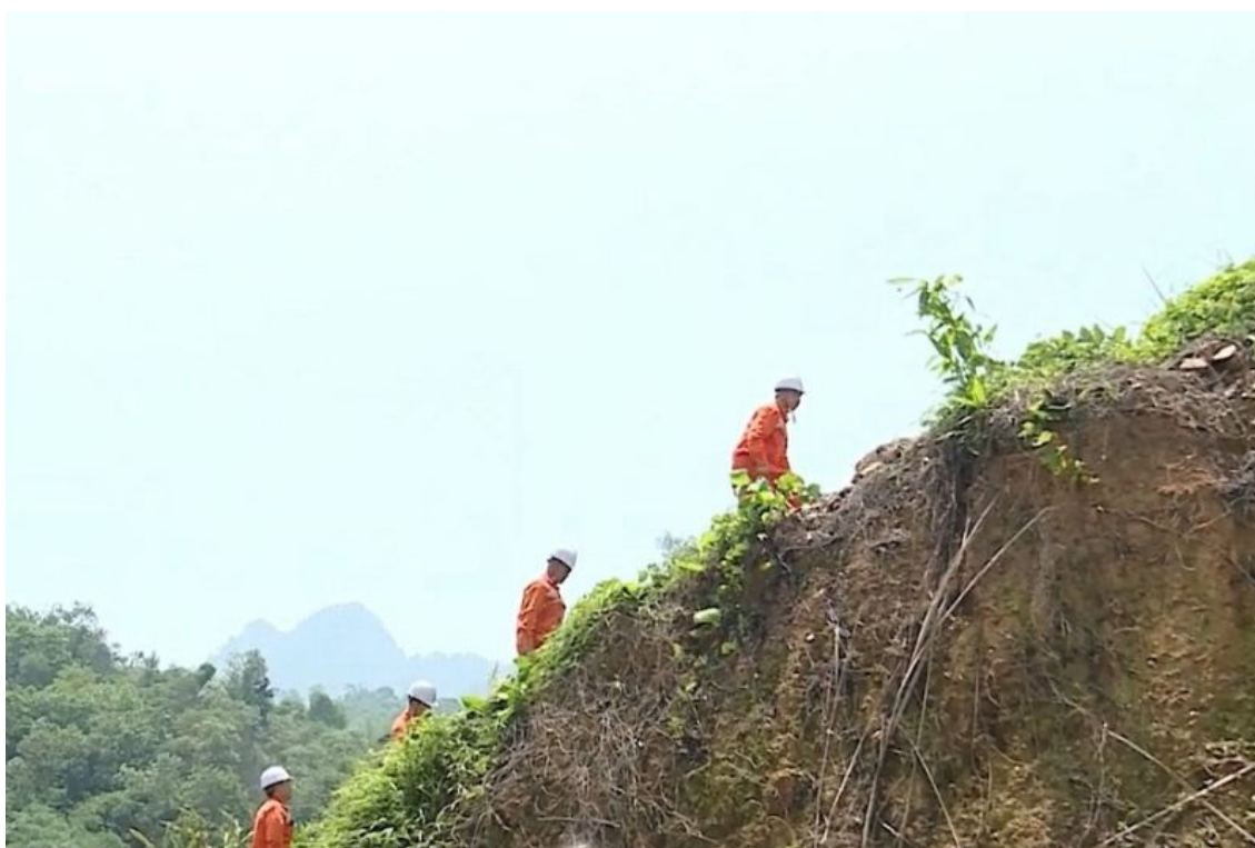
Điện lực Na Hang (PC Tuyên Quang) kiểm tra hành lang lưới điện trên địa bàn
