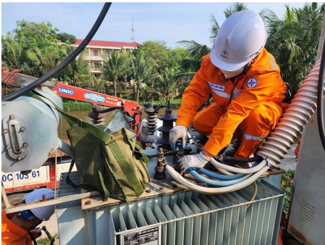
Sửa chữa bảo dưỡng máy biến áp
