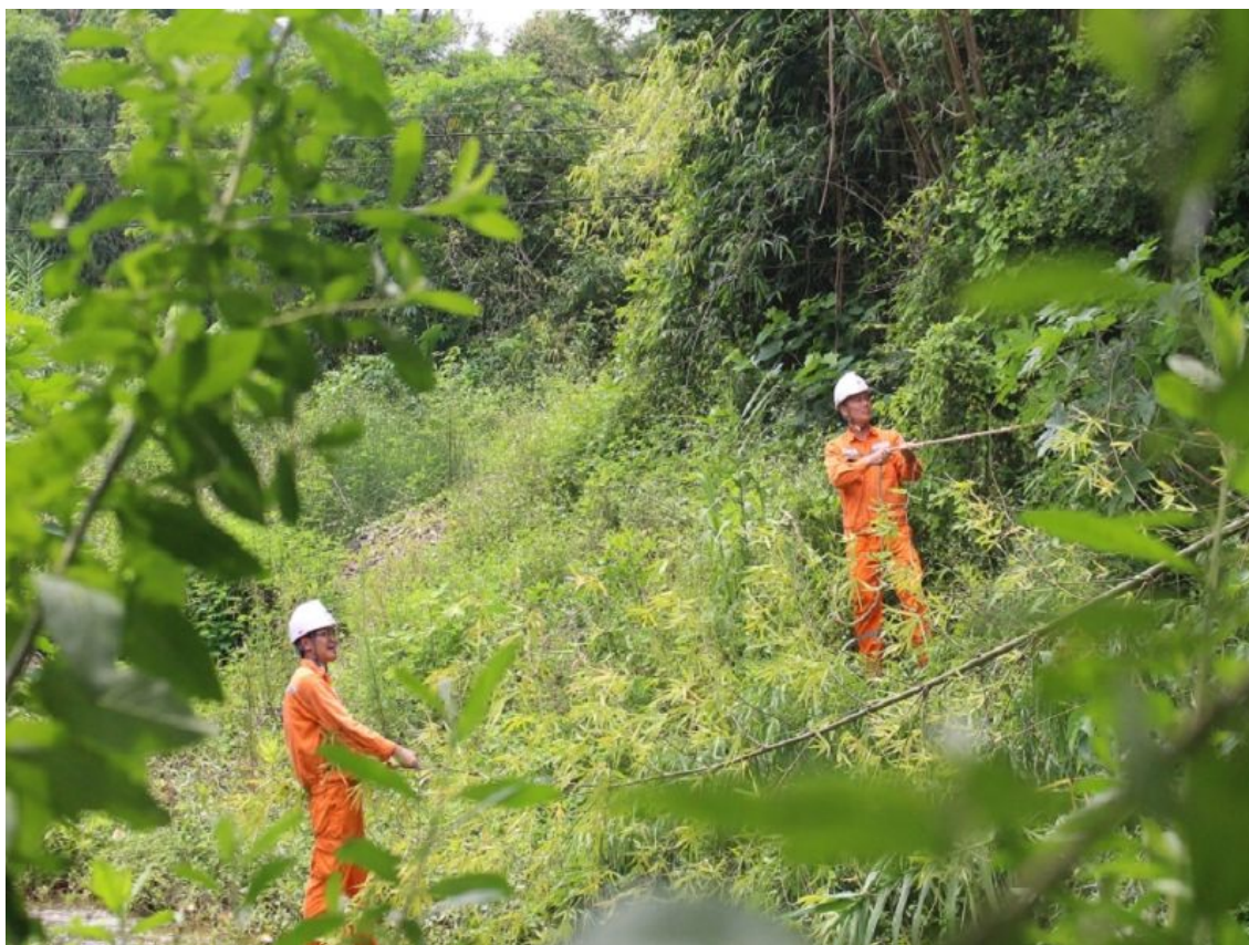
Điện lực Chi Lăng (PC Lạng Sơn) phát quang hành lang bảo vệ hành lang an toàn lưới điện
