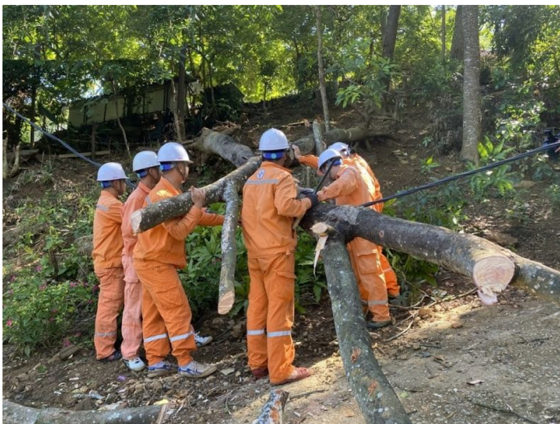
Công nhân Điện lực Mường La (PC Sơn La) thực hiện cắt bỏ phần thân cây đè lên đường dây điện
