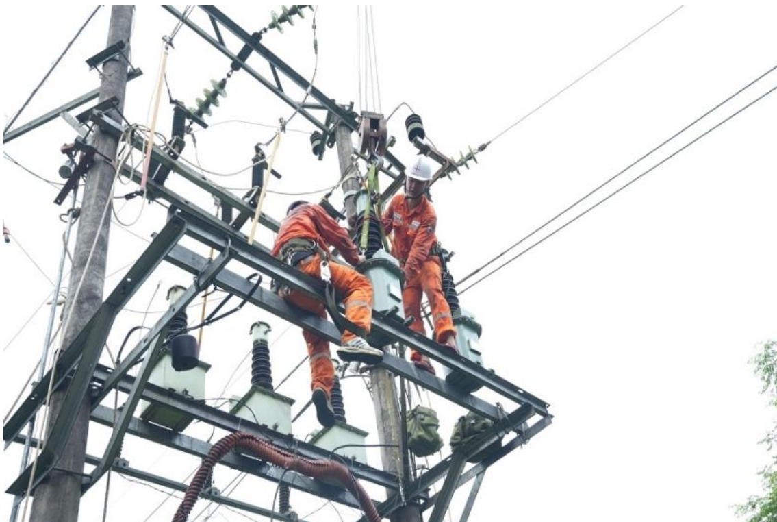
Điện lực Na Hang (PC Tuyên Quang) sửa chữa khiếm khuyết trên đường dây
