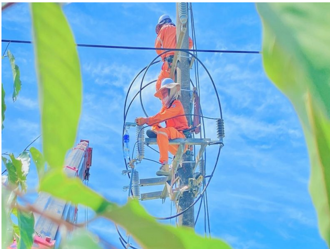
Công nhân Điện lực Hà Tĩnh tăng cường sửa chữa, thay thế thiết bị đảm bảo cung ứng điện an toàn, liên tục, ổn định
