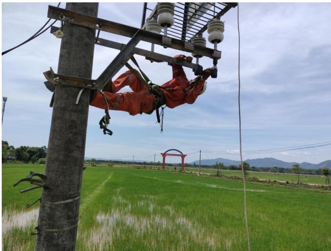
Công nhân Điện lực Hương Khê (PC Hà Tĩnh) xử lý các lỗi trên hệ thống đường dây, thay thế thiết bị, dây dẫn
