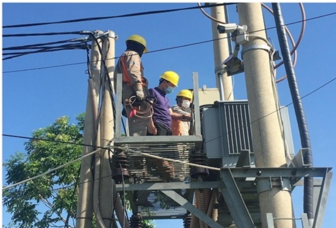
Lãnh đạo Công ty Điện lực Nghệ An trực tiếp xuống hiện trường kiểm tra công tác chuẩn bị
