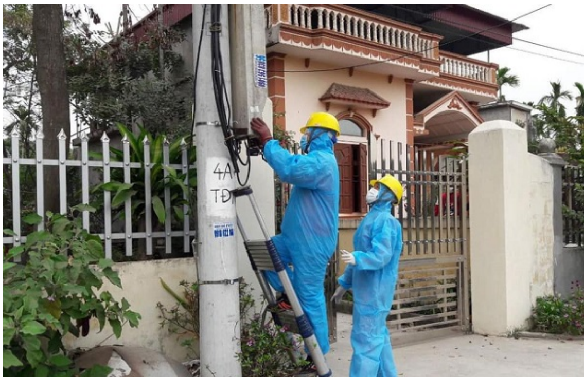
Công nhân Điện lực Chí Linh sửa chữa điện cho nhân dân tại phường Cộng Hòa, TP Chí Linh - khu vực bị phong tỏa
