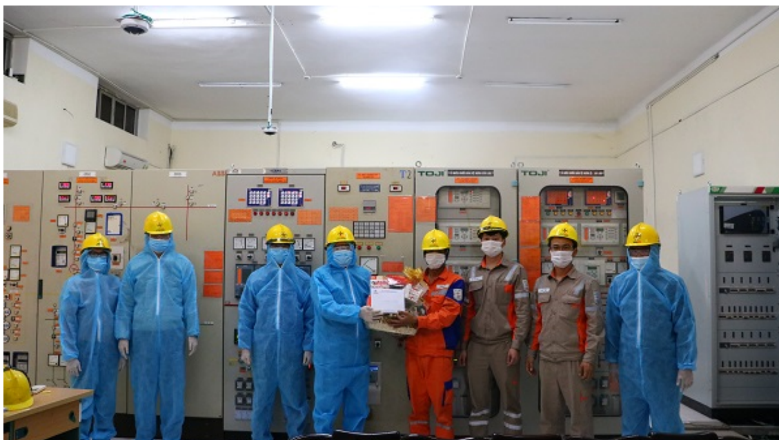
Công đoàn Hải Dương tặng quà trạm 110kV Chí Linh
