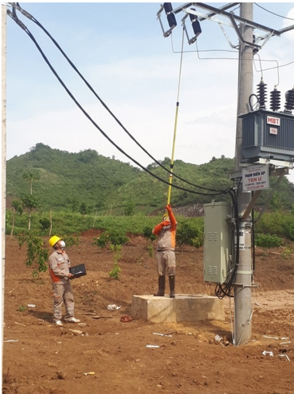
Công nhân Điện lực Sông Mã thực hiện đóng điện vào trạm biến áp Ten Ủ
