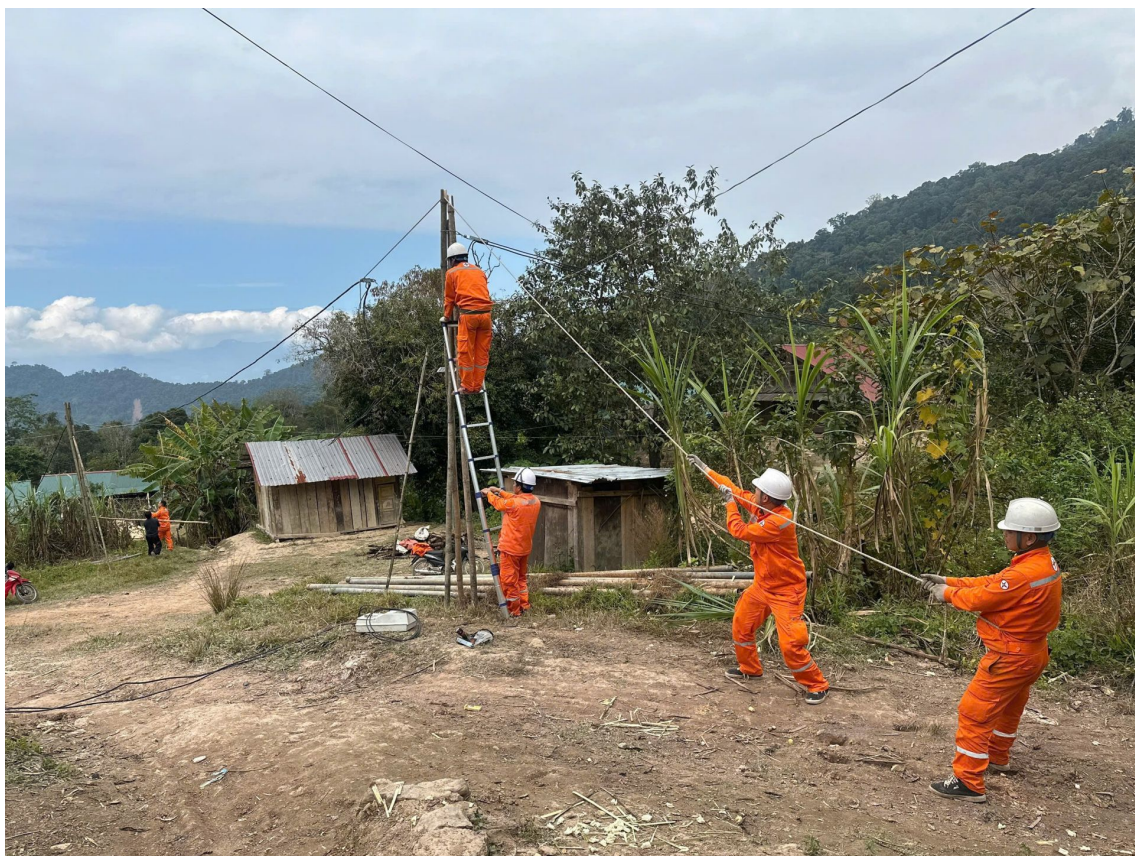
Công nhân EVNNPC phối hợp kéo dây, dựng cột, thi công đường dây điện tại các thôn, bản vùng cao
