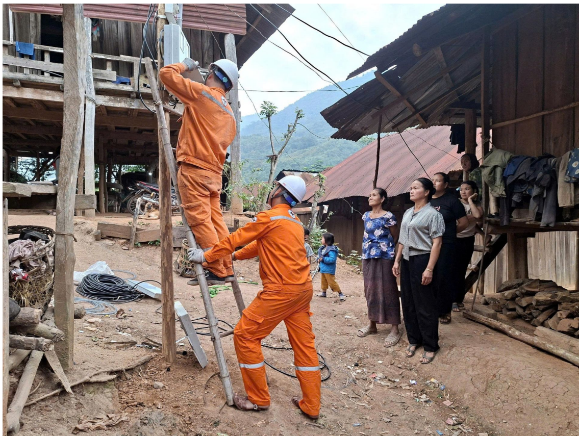
Công nhân EVNNPC lắp đặt công tơ, kéo điện vào từng hộ dân, đưa ánh sáng về các bản làng vùng cao
