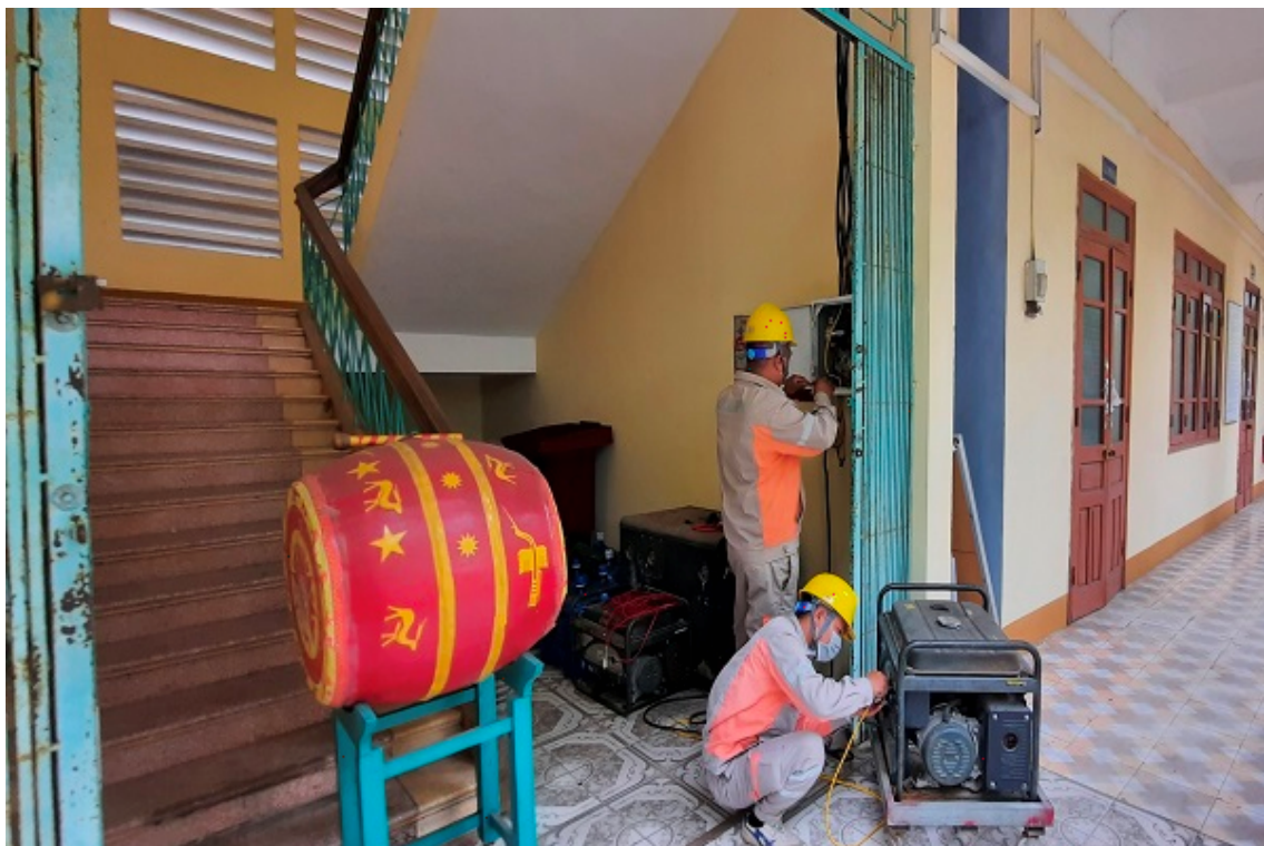
Máy phát điện được chuẩn bị tại các điểm thi ở Quảng Ninh
