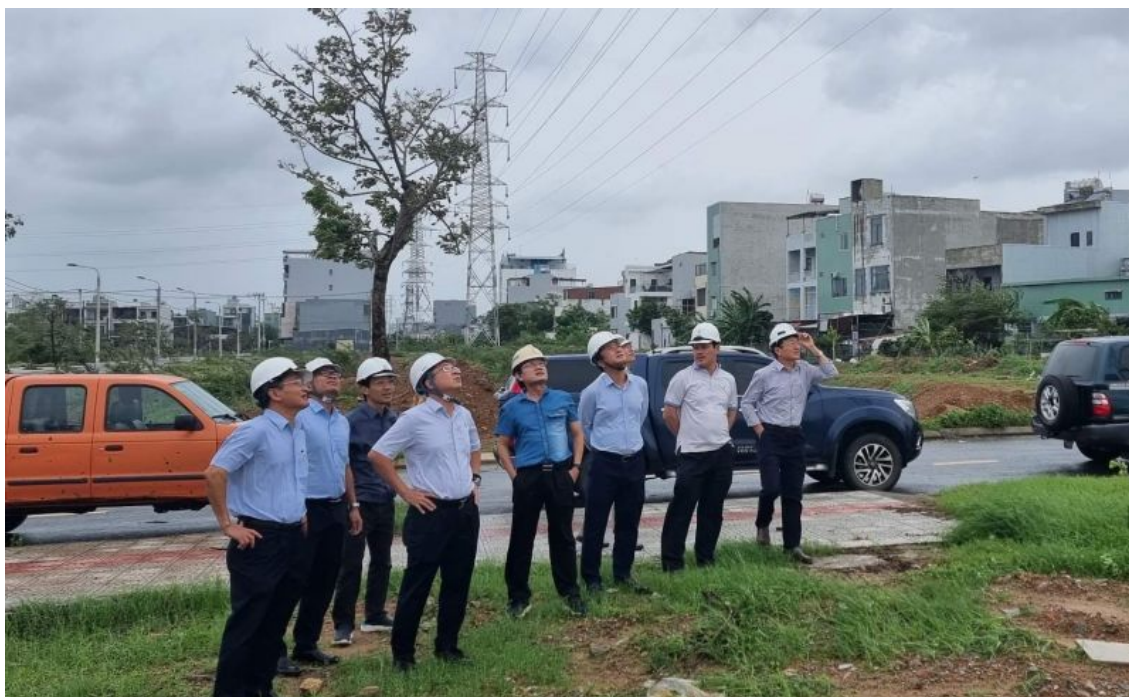
Đoàn công tác của EVNNPT kiểm tra đường dây truyền tải, sáng ngày 28/9.
