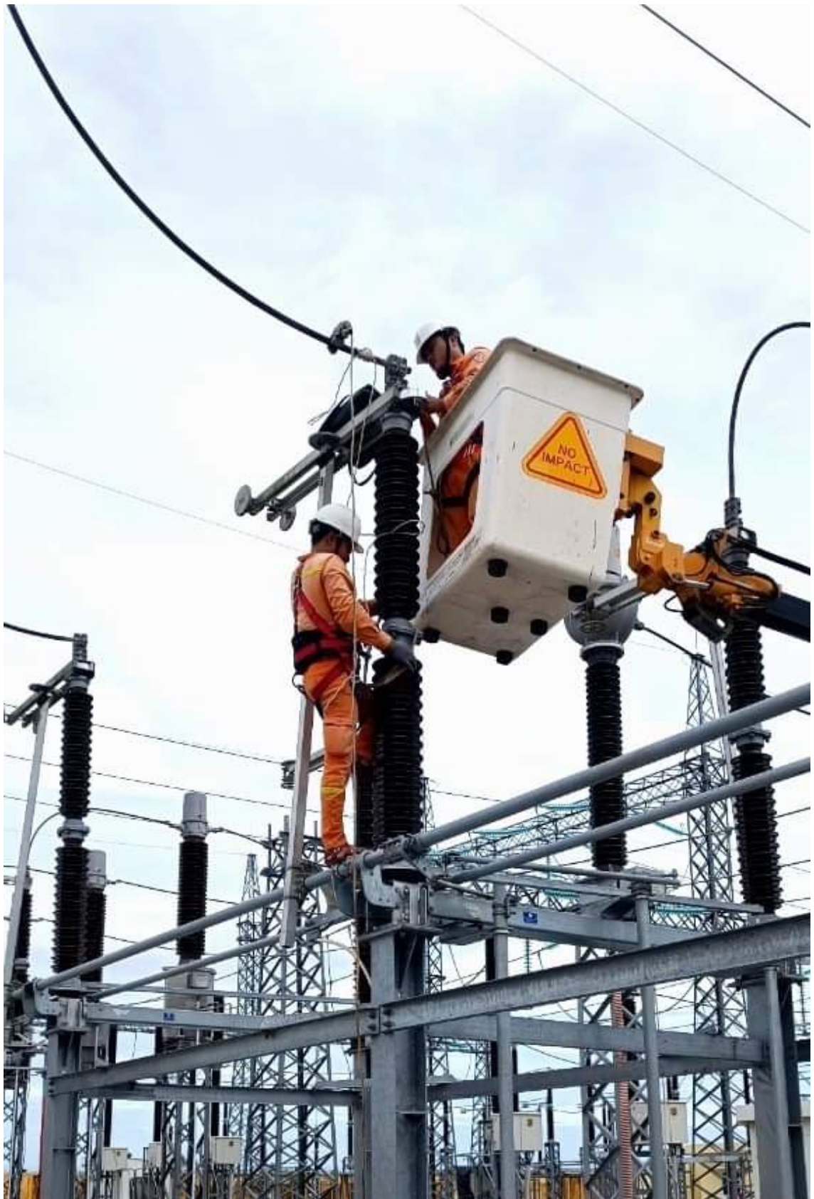
Xử lý thiết bị sau bão số 4 tại TBA 500kV Dốc Sỏi.
