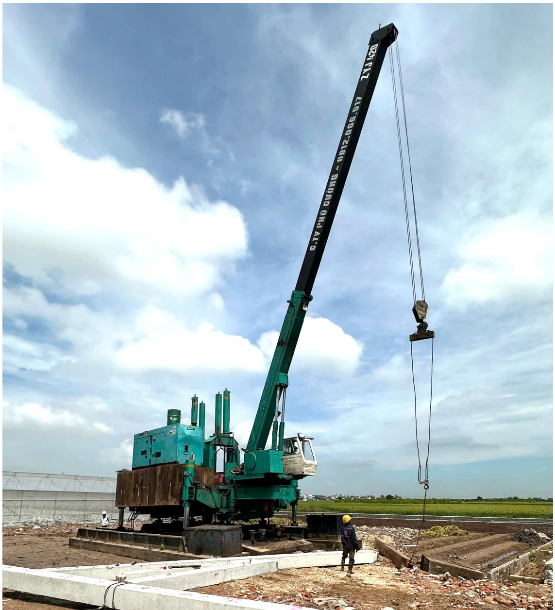
Thi công ép cọc một vị trí móng Dự án đường dây 500kV Hải Phòng – Thái Bình
