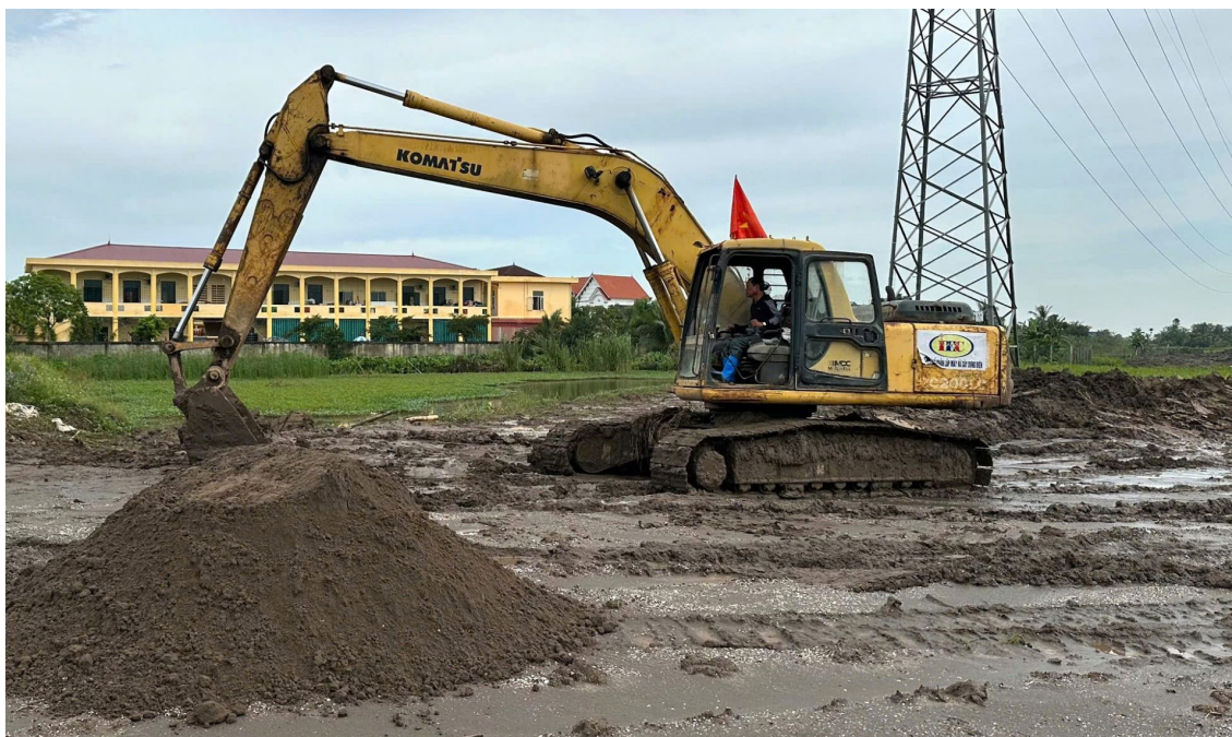
Thi công đường công vụ vào vị trí móng phục vụ thi công Dự án đường dây 500kV Hải Phòng – Thái Bình
