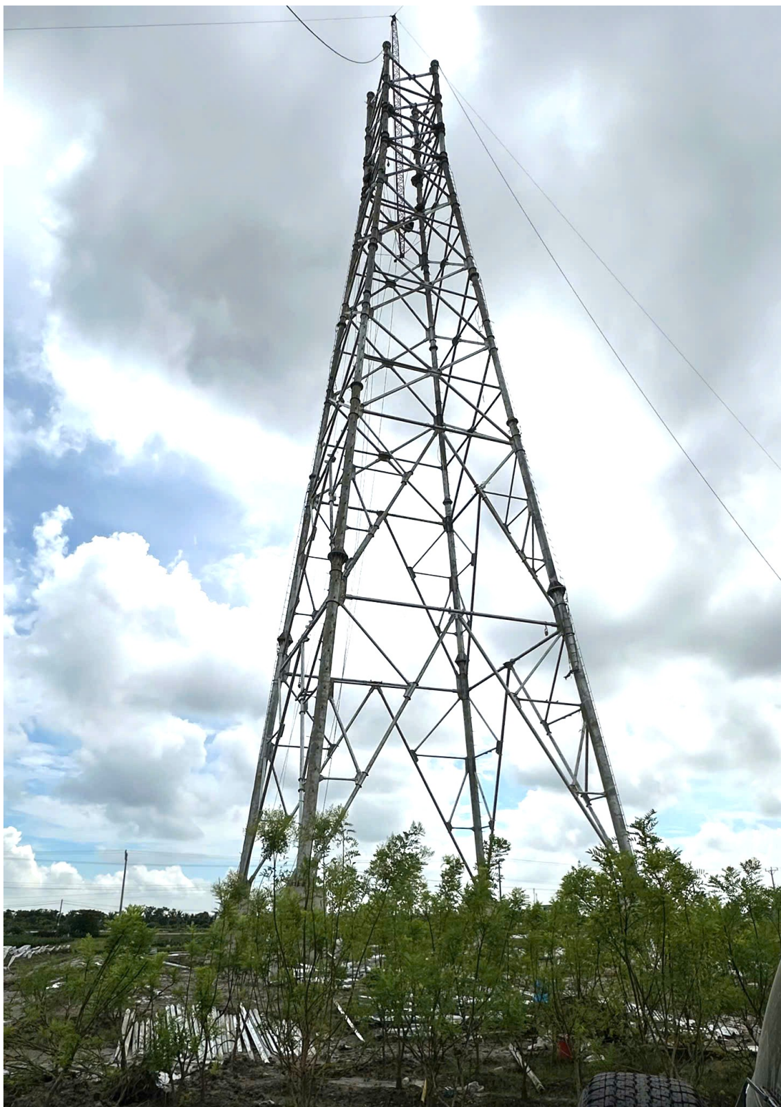
Một vị trí cột Dự án đường dây 500kV Hải Phòng – Thái Bình đang được gần hoàn thiện
