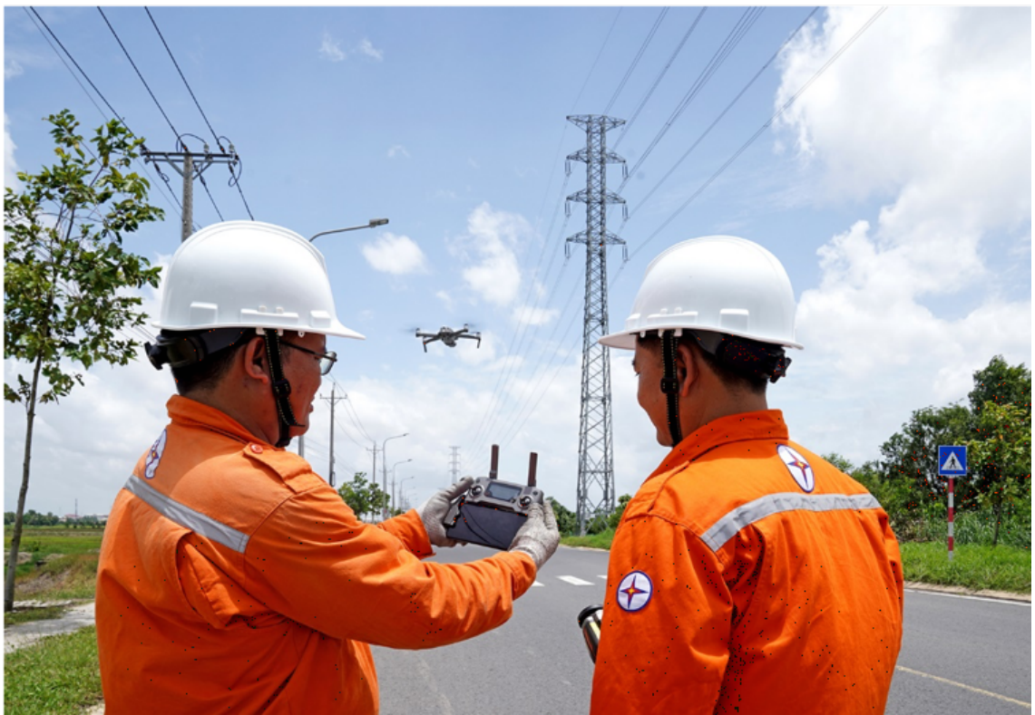
Nhân viên của EVNSPC ứng dụng thiết bị flycam trong công tác kiểm tra lưới điện
