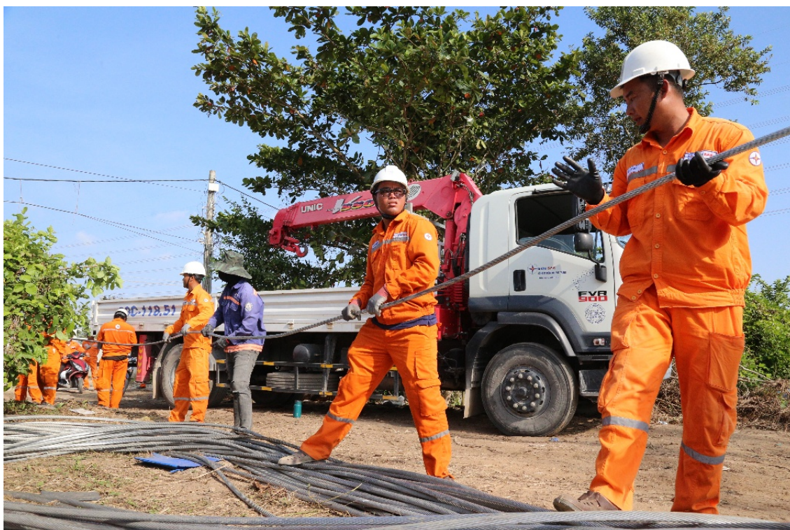
Công nhân các nhà thầu miệt mài lao động trên công trường Công trình "Xuất tuyến 4 mạch đường dây 110kV Trạm 220kV Năm Căn" trong ngày 1/1/2026
