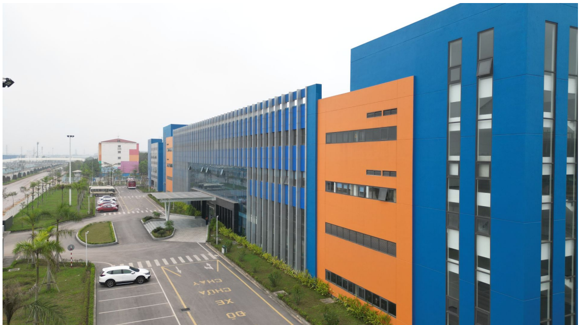
Nhà máy Sunny Optech Việt Nam tại Thái Nguyên.
