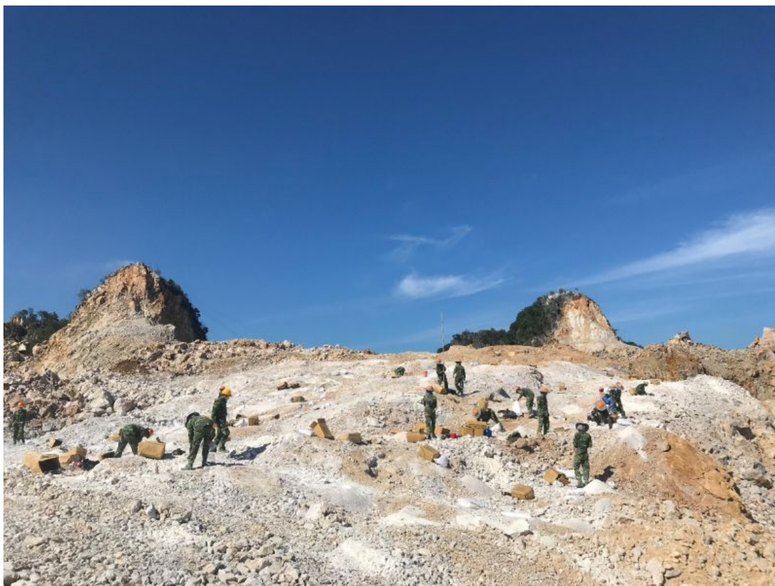
Công nhân GAET tại công trường thi công Vật liệu nổ
