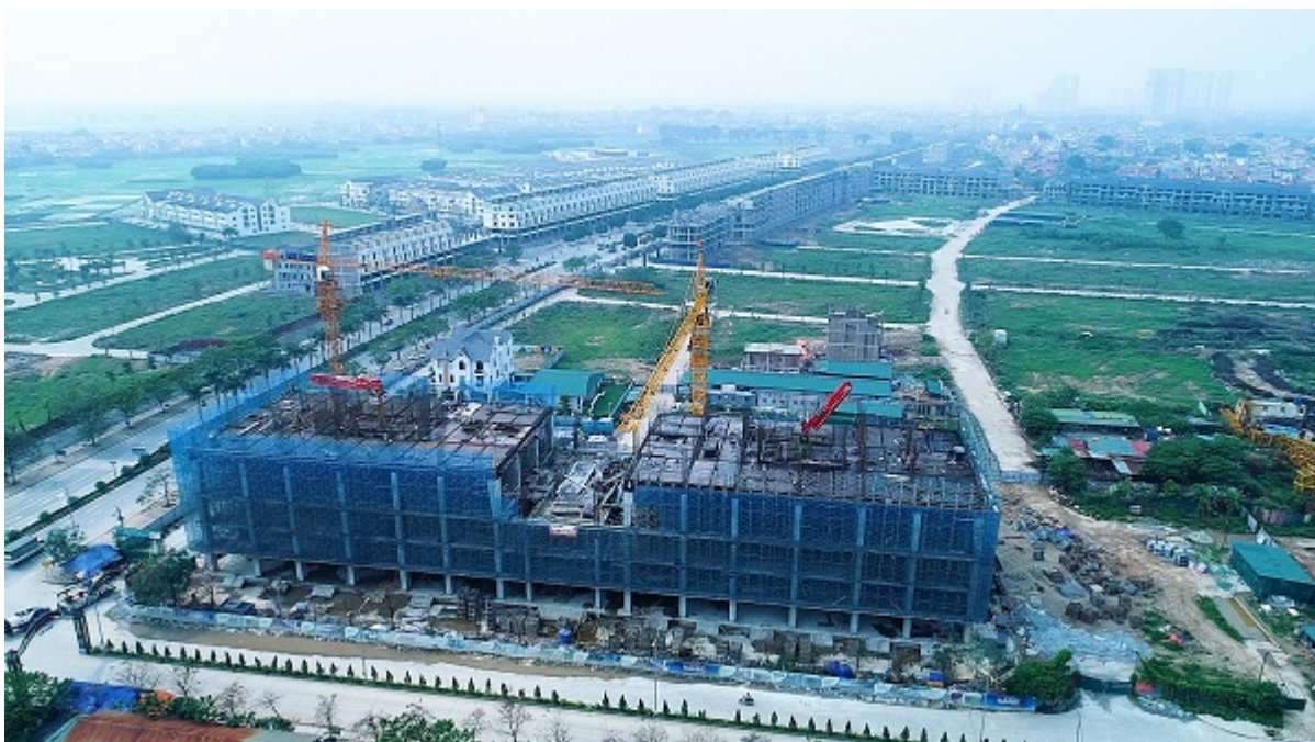
Hình ảnh thực tế dự án đang thi công đến tầng 6
