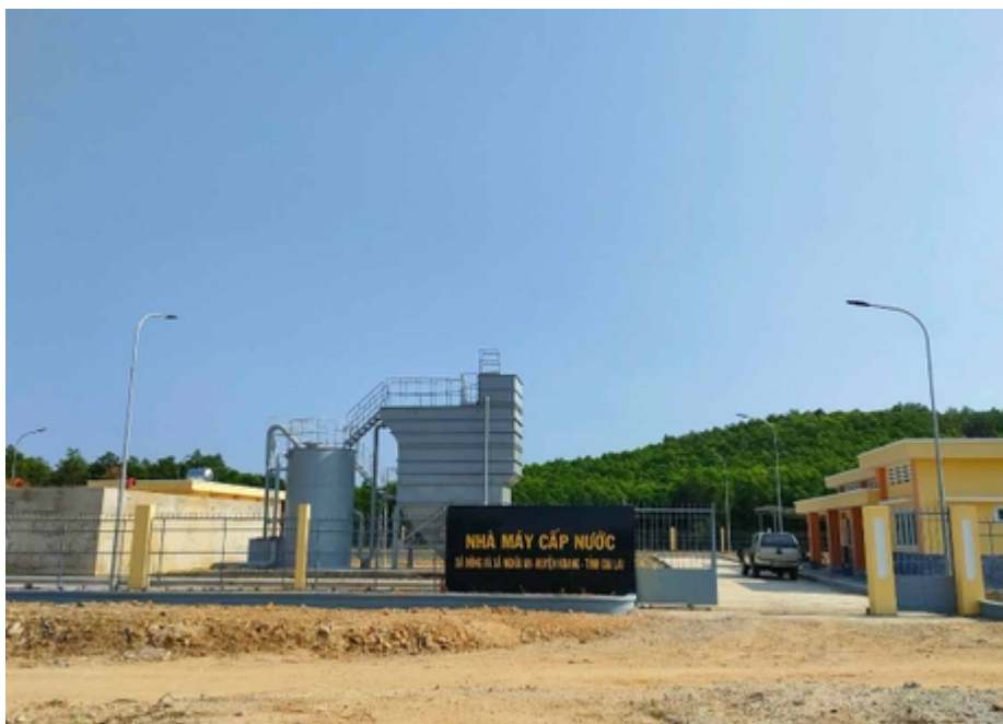
Nhà máy cấp nước sinh hoạt xã Đông và Nghĩa An, huyện Kbang (Ảnh: Nguyễn Diệp)
