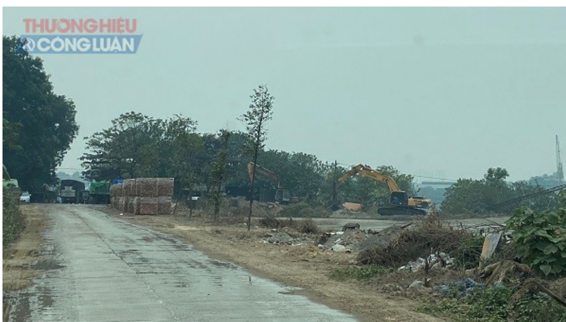
Tuyến đường dẫn ra bãi trung chuyển vật liệu xây dựng tại Khu Chéo Phà, xã Kim Lan. Ảnh: Công Hoàng.
