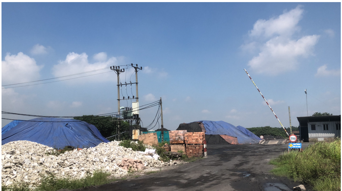
Bãi tập kết than vẫn chưa bị xử lý
